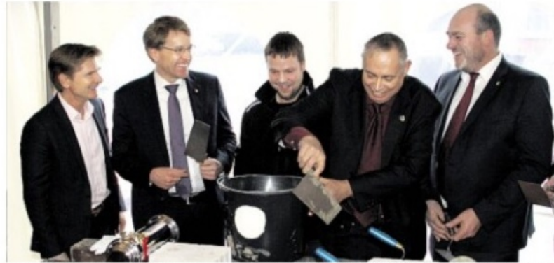
Legten den Grundstein für das neue „Hospiz im Dänischen Wohl“ in Gettorf: (von links) Sozialminister Dr. Heiner Garg, Ministerpräsident Daniel Günther, der Geschäftsführer des zuständigen Bauunternehmens Wrobel, Jan Henrik Johannsen, Gettorfs stellvertretender Bürgermeister Joachim Wendt-Köhler und Amtsvorsteher Jens Krabbenhöft. FOTOS: PETERS
